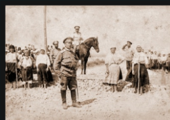
Munci forțate. Construcția drumului strategic Holin - Malini
