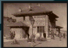
Stație pe linia de cale ferată Revacca-Căinari
